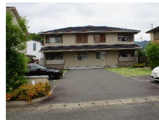
n16-1 2階建共同住宅。 駐車場入り口に塀を設置し、前面に高木を含む植栽帯を設けている例。(2012年建築)
