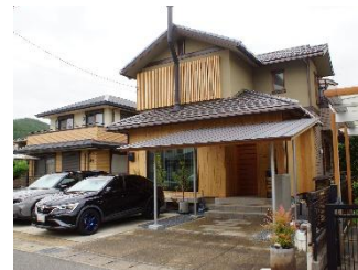
n18-1 2階建住宅。 自然素材利用が路線内で最大。格子は伝統要素として検出。(2005年建築)
