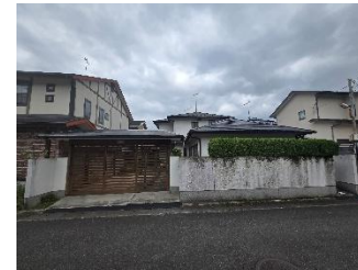
s03-1 2階建住宅。 植栽が塀の内側に植えられ、塀を超えた部分を生垣として剪定されている。路線で最も古い建物。(1988年建築)
