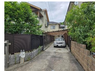
n06-1 2階建住宅。 旗竿敷地に建ち、D/H最大(3.4)。外からは敷地内の植栽は見られない。(2011年建築)
