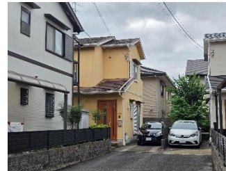
s15-1 2階建住宅。 外壁にYR系の明るい色が用いられた例。(2004年建築)
