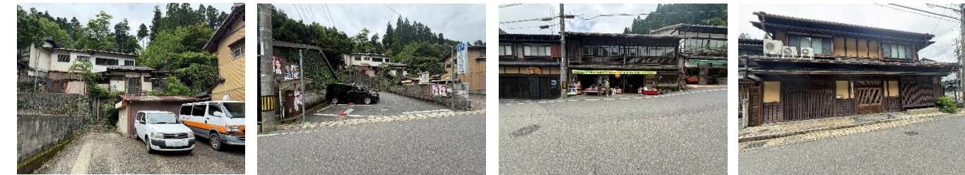
w10-1 1階建倉庫。奥の擁壁の上に住宅が控え、アプローチを兼ねている。倉庫のD/Hが路線で最大。(5.1)(建築年不明) w11 駐車場。建替えない敷地は駐車場となっている。 w16-1 2階建店舗。高二階町家形式の店舗。D/Hは1.2。建築年は1969年以前とみられる。(建築年不明) w20-1 2階建住宅。高二階町家形式の住宅。自然素材を用いている。(1994年建築)
