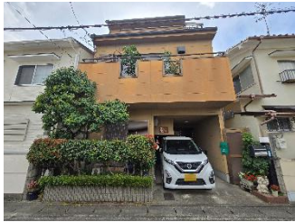
w25-1 3階建住宅。 生垣を設置した建物で最も新 しい例。(1997年建築)
