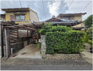
w04-1 2階建住宅。 生垣と駐車場を両立した例。 (建築年不明)
