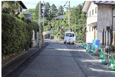
④N-pt03: A-1)空の割合、A-2)緑視率 山裾の住宅内(路線区間より北側)の針葉樹によって、空の割合が減少している。
