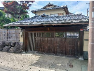
n05-1 2階建住宅。前面に石垣及び竹垣を配し、駐車場を板張りの門で隠した例。(1977年建築)
