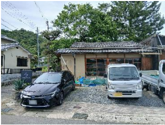
n01-1 1階建工房兼住宅。建物左側に、高木のみ見える。年代の比較的古い建物であるが塀のないオープン駐車場である。(1967年建築)
