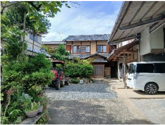
n12-1 2階建住宅。塀が石垣および生垣で、主屋も塗り壁、建具木製、外構砂利舗装。自然素材使用が路線内で最大。(1969年建築)
