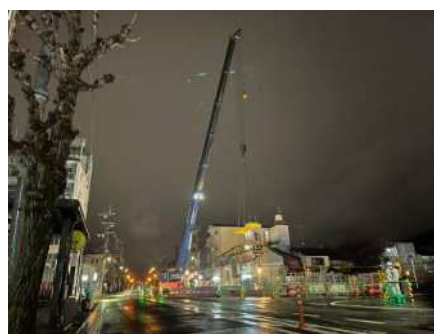
■橋桁の撤去・架設工事
