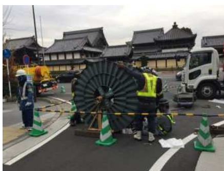
■下水道管更生の施工状況
