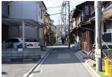
1 妻面の露出（蘆山寺通）
