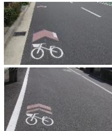
図 本市の矢羽根の路面表示 （上：幹線道路、下：生活道路）
