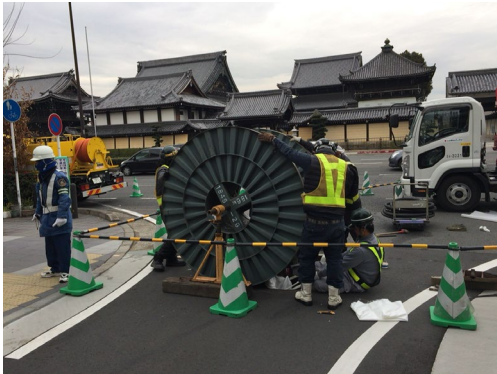
■下水道管更生の施工状況
