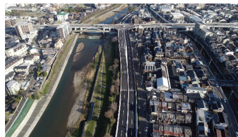
■鴨川東岸線（第二工区）
