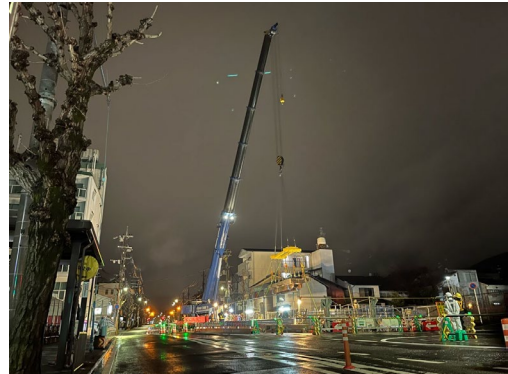
■橋桁の撤去・架設工事
