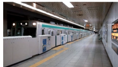
図 3-67 可動式ホーム柵（地下鉄 烏丸御池駅）
