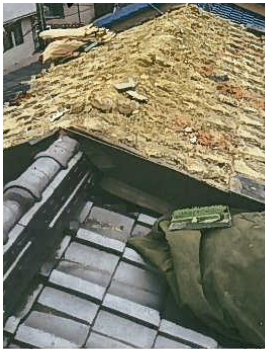
屋根の軽量化（屋根の葺き方を土葺き⇒引っ掛け棧瓦葺きに変更）
