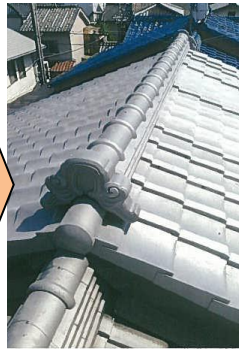
屋根の軽量化（屋根の葺き方を土葺き⇒引っ掛け棧瓦葺きに変更）
