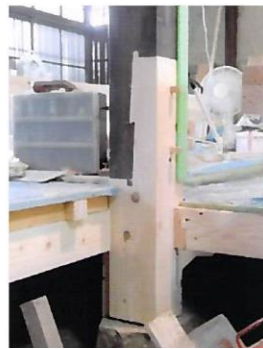
柱等の劣化修繕
