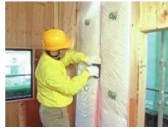
外壁への断熱材設置
