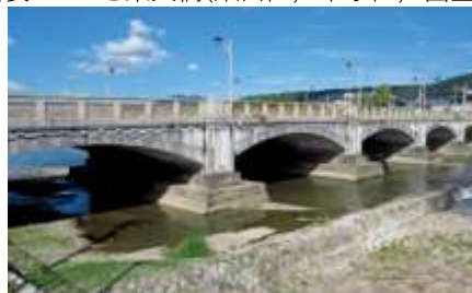
図表 48 七条大橋(東山区, 下京区, 国登録)
