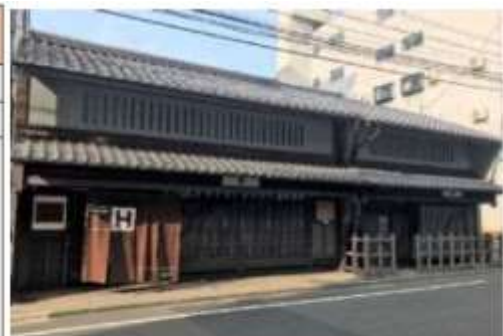
外観（右側が主屋北棟）
