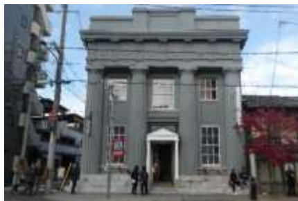
図表 115 ザックホール （下京区、界わい景観建造物）
