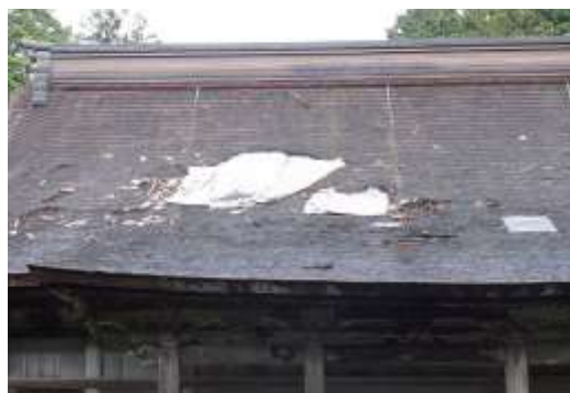
図表 11 平成29年、30年の強風により毀損した勝林院本堂
