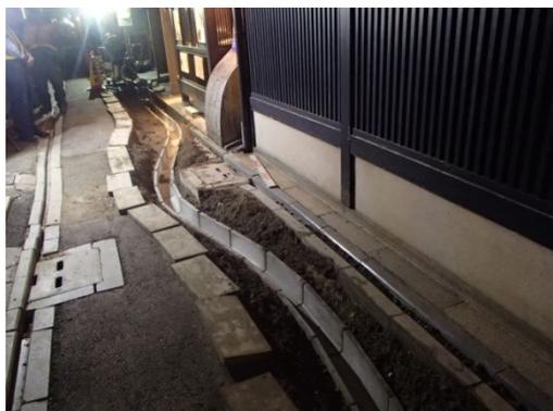
写真5-1 小型ボックス活用埋設方式の事例
