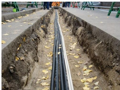
写真5-2 直接埋設方式の実験状況
