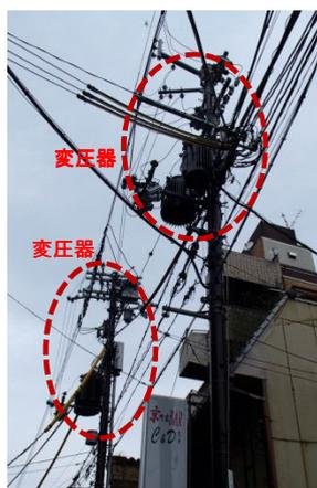
写真4-1 電柱に共架された変圧器等
