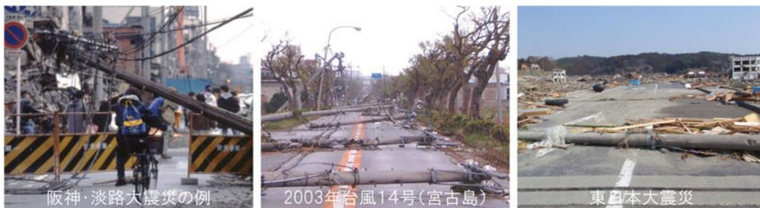
写真3-2 災害による電柱倒壊事例
