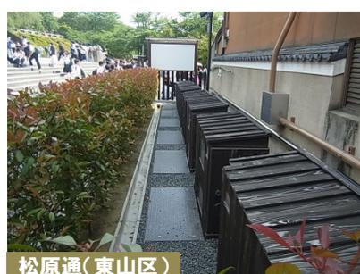
写真5-3 地上機器の民有地への設置事例
