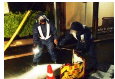
漏水等に伴いにごり水が発生した場合の洗管作業の様子
