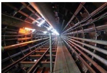
雨水幹線（施工中）の内部の様子
