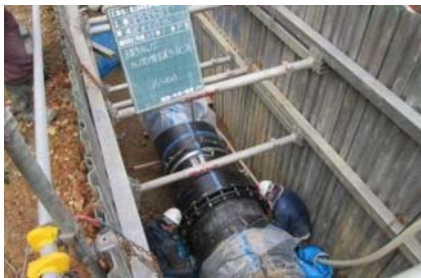
配水管の更新（耐震化）の様子
