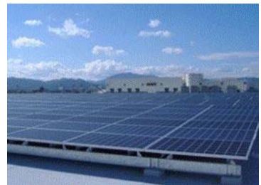
大規模太陽光発電設備（鳥羽水環境保全センター）
