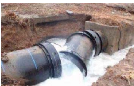
東日本大震災による水道管の継ぎ手離脱
