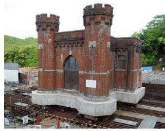
蹴上浄水場第 1 高区配水池 （外観を保存する工法による改築更新の様子）
