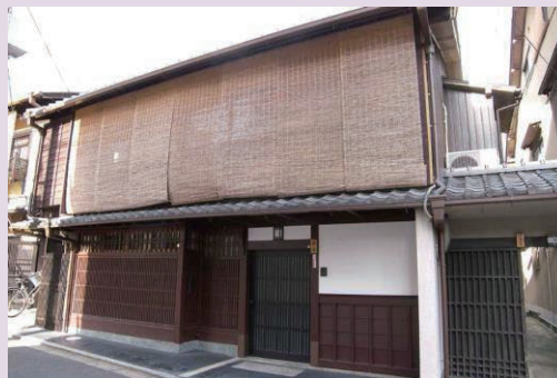
京町家再生の受賞例 ＜平成26年度建築部門＞
