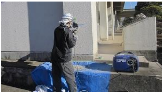
コンクリートコア採取の様子
