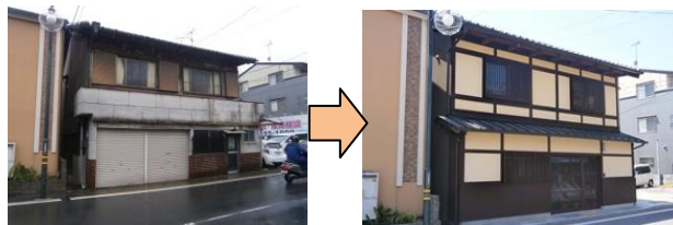
空き家の改修・活用事例（障害をお持ちの方の就労継続支援施設）
