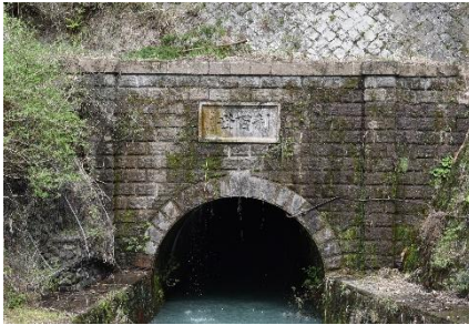
旧高津尾発電所トンネル 扁額「利百世」
