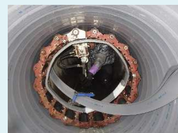
下水道管路の更生工事
