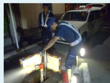
配水管の洗浄作業 (消火栓操作)
