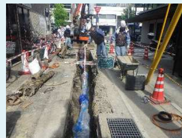
配水管の更新工事
