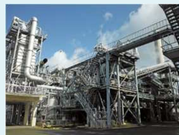
鳥羽水環境保全センター汚泥焼却炉
