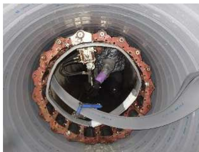
下水道管路の更生工事
