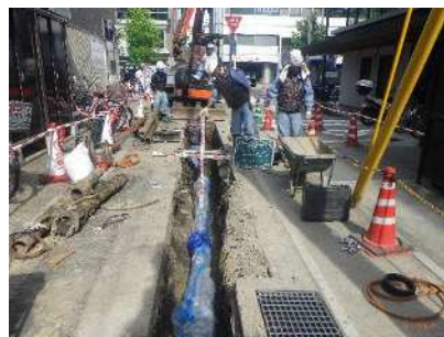
水道配水管の布設替工事
