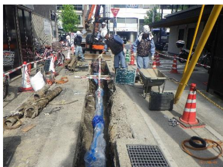
配水管の更新工事
