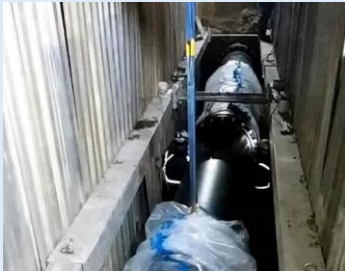
配水管の 更新工事
