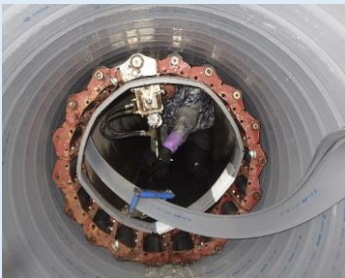
下水道管路の 更生工事
