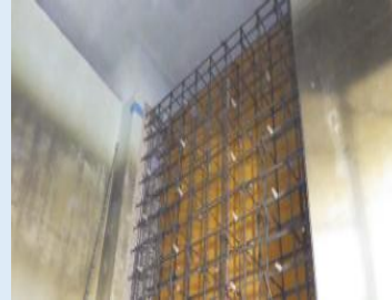
配水池の 耐震化工事
