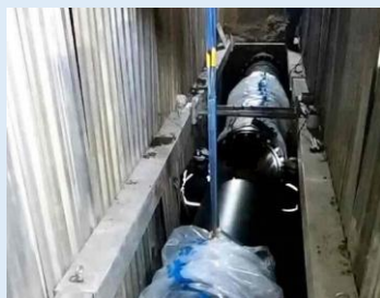
配水管の更新工事
