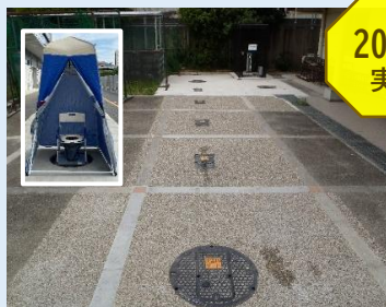
災害用マンホールトイレ (左上は設置の様子)
