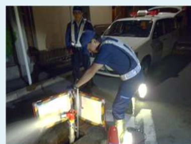
配水管の洗浄作業 (消火栓操作)
