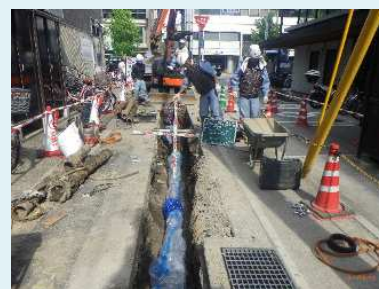
配水管の更新工事
