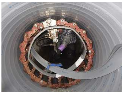
下水道管路の更生工事
