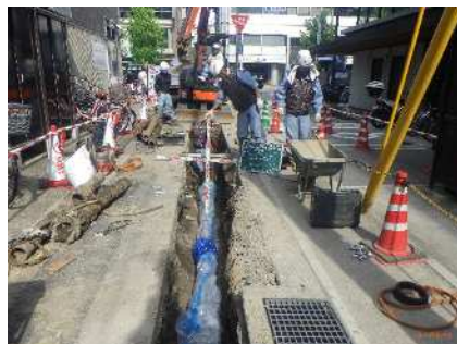
水道配水管の布設替工事
