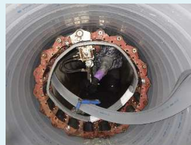
下水道管路の更生工事
