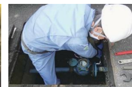
水道メーター関連作業
