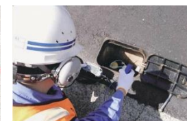
漏水調査作業
