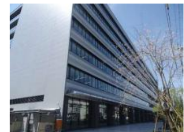
京都市上下水道局総合庁舎
