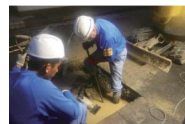
漏水修繕作業
