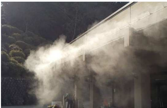
配管型ミスト（蹴上浄水場）
