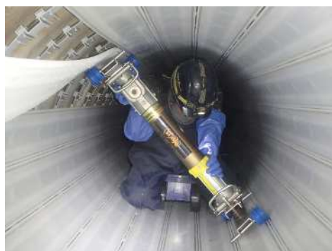
下水道管路の更生工事
