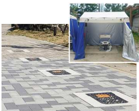
災害用マンホールトイレ （右上は設置時の様子）
