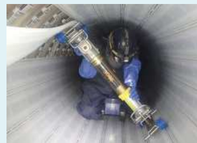
下水道管路の更生工事
