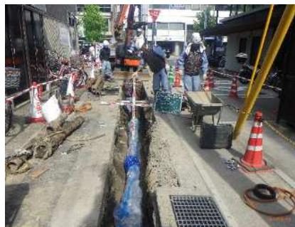
水道配水管の布設替工事
