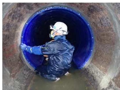
下水道管路の更生工事
