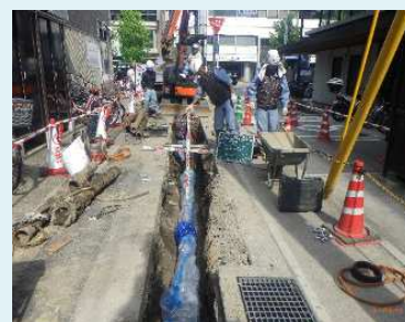
配水管の更新工事
