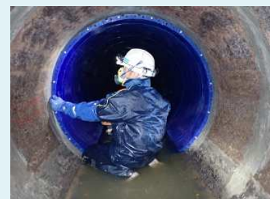
下水道管路の更生工事
