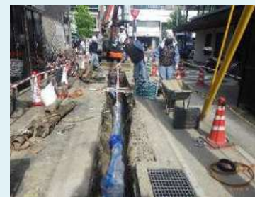
配水管の更新工事
