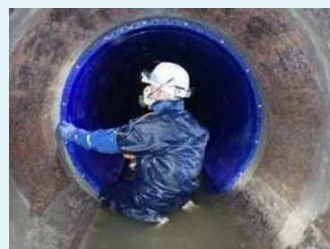
下水道管路の更生工事
