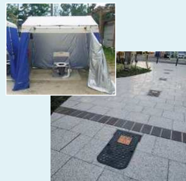
マンホールトイレ (左上は設置時の様子)
