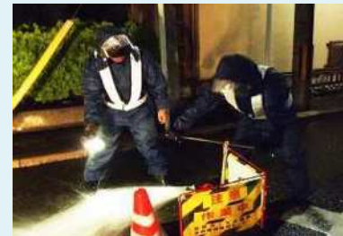
配水管の洗浄作業 (消火栓放水)
