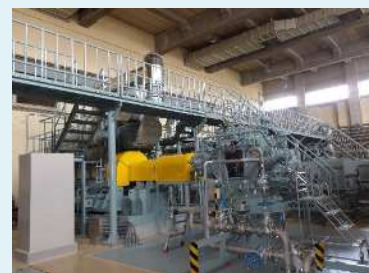
処理施設の改築更新の様子 (鳥羽水環境保全センター第2東ポンプ場)
