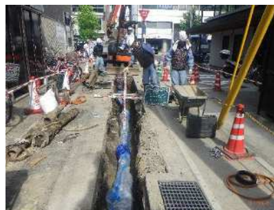
水道配水管の布設替工事
