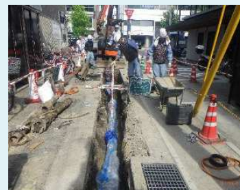
配水管の更新工事
