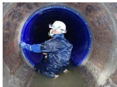
下水道管路の更生工事
