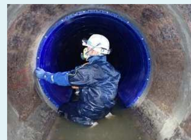
下水道管路の更生工事
