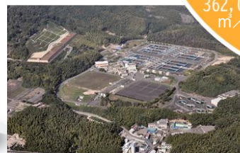
新山科浄水場
