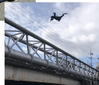
ドローンによる 水管橋点検調査
