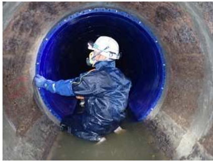
下水道管路の更生工事
