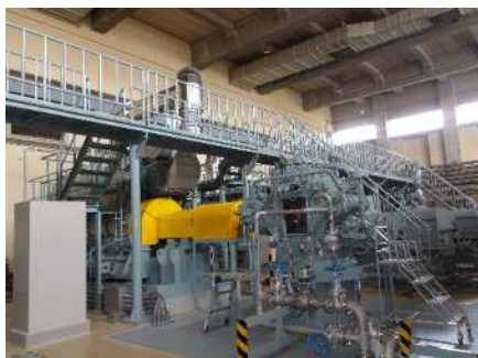
鳥羽水環境保全センター（第2東ポンプ場）
