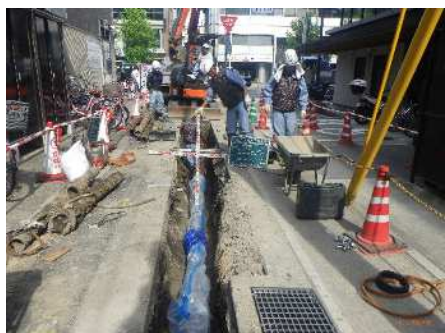
配水管の更新工事
