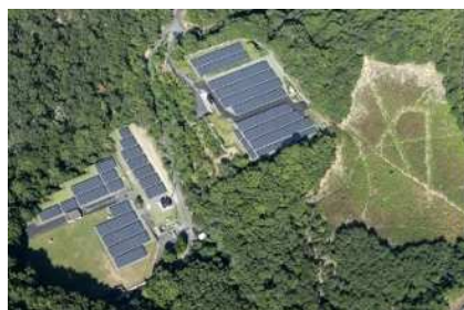
太陽光発電設備 （松ヶ崎浄水場）
