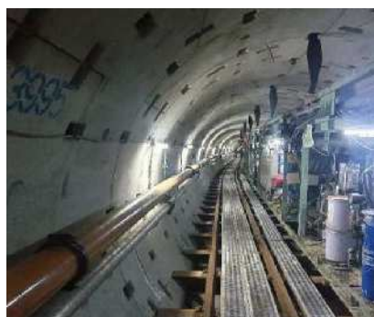
新山科浄水場導水トンネル築造工事 （トンネル掘進の様子）
