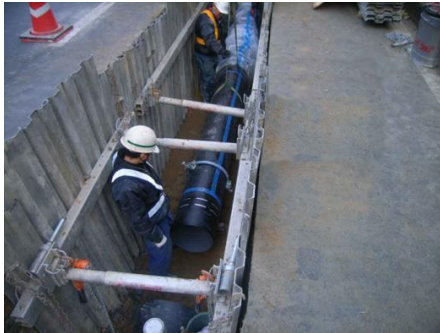
(配水管工事の様子)
