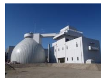
汚泥消化タンク
