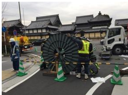
(下水道管路の更生工事の様子)
