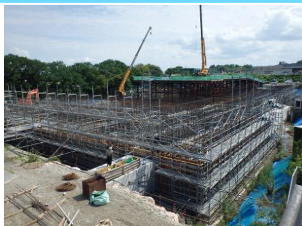
(下水処理施設の改築工事の様子)
