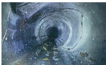
（管路内調査画像（下水道））
