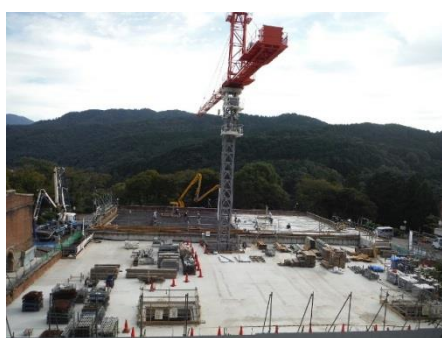
（配水池更新工事の様子）
