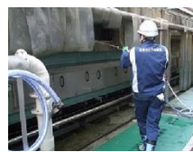
施設の点検・洗浄
