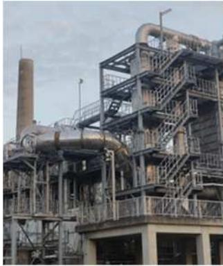
鳥羽水環境保全センター汚泥焼却炉
