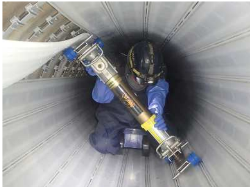
下水道管路の更生工事
