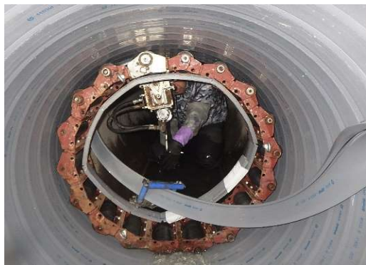
下水道管路の更生工事
