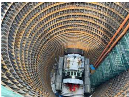
鳥羽第3導水きょ（発進立坑）
