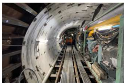
新山科浄水場導水トンネル築造工事 （トンネル掘進の様子）
