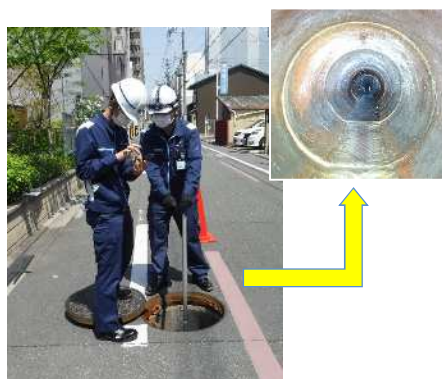
高画質カメラによる調査試行状況
