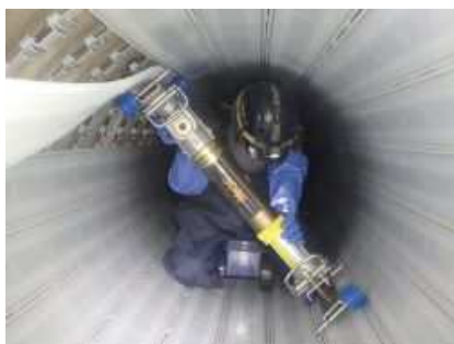
下水道管路の更生工事
