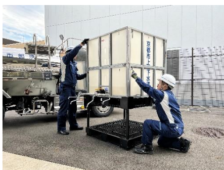
仮設給水槽（組立ての様子）
