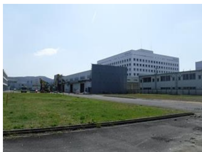
元資器材・防災センター西側用地
