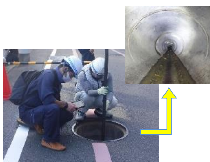
高画質カメラによる調査試行状況
