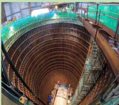
「鳥羽第3導水きよ」は市内中心部における浸水安全度の向上を目的とした雨水幹線です。現在、シールドマシンを使って、市内を南から北へと掘り進めており、その過程を見学しました。
