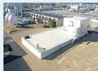
鳥羽水環境保全センター消毒施設 (塩素混和池)
