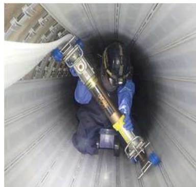
下水道管路の更生工事
