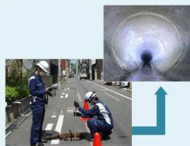
高画質カメラによる調査試行状況
