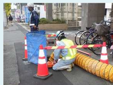
下水道管路の巡視・点検の様子
