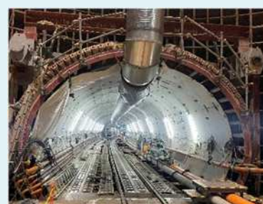
鳥羽第3導水きょ (発進立坑)
