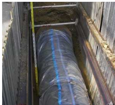
水道配水管の布設替工事
