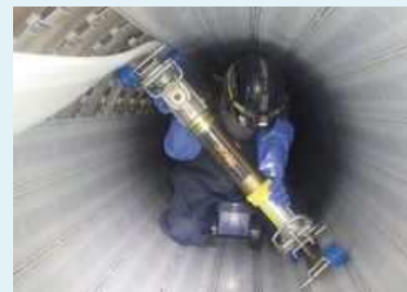
下水道管路の更生工事
