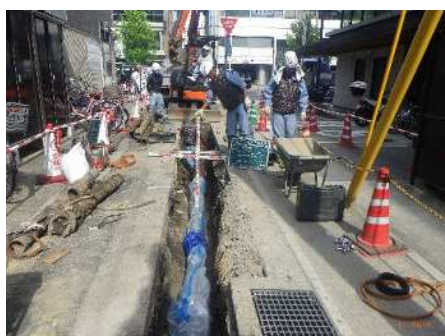
配水管の更新工事
