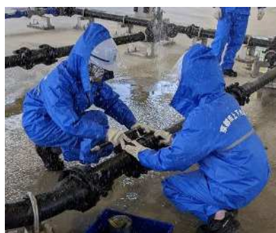
水道技術研修施設における研修 (水道管の修繕研修の様子)
