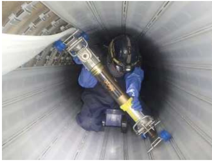
下水道管路の更生工事
