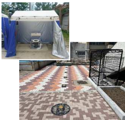
災害用マンホールトイレ （左上は設置時の様子）
