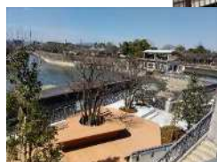
琵琶湖疏水記念館 地階デッキテラス
