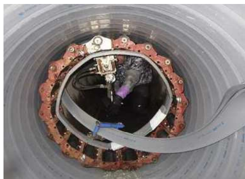
下水道管路の更生工事
