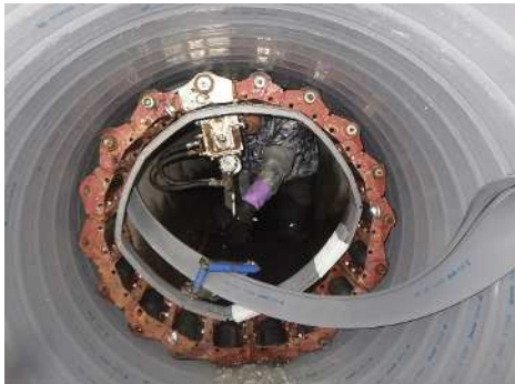
下水道管路の更生工事
