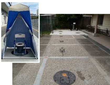
災害用マンホールトイレ （左上は設置時の様子）
