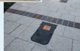
マンホールトイレ (左上は設置時の様子)
