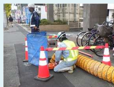
下水道管路の巡視・点検の様子
