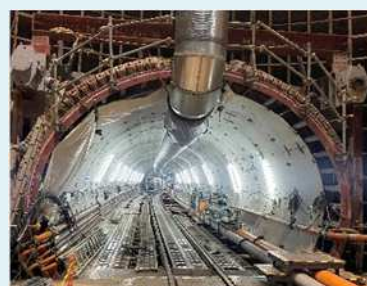
鳥羽第3導水きょ (発進立坑)
