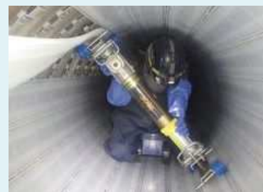
下水道管路の更生工事
