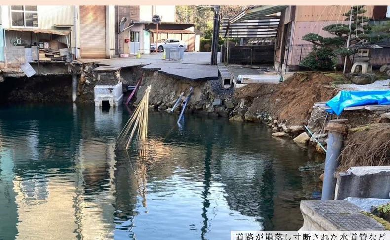
道路が崩落し寸断された水道管など
