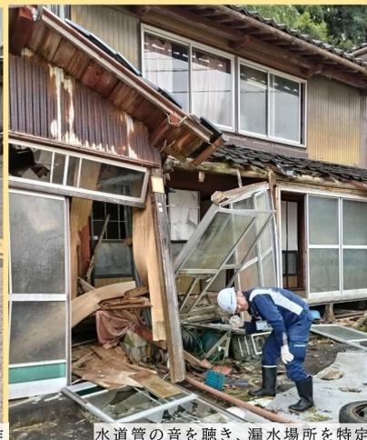
水道管の音を聴き、漏水場所を特定
