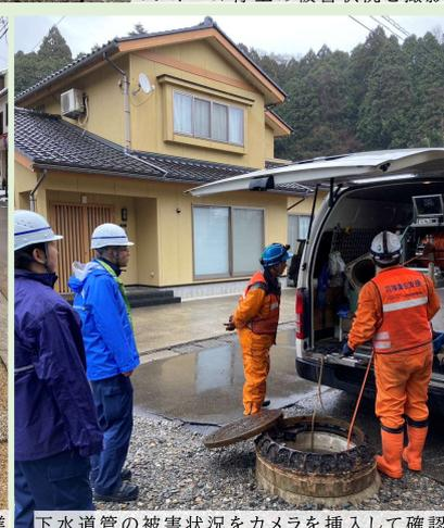
下水道管の被害状況をカメラを挿入して確認
