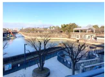
改修前の地階テラス
