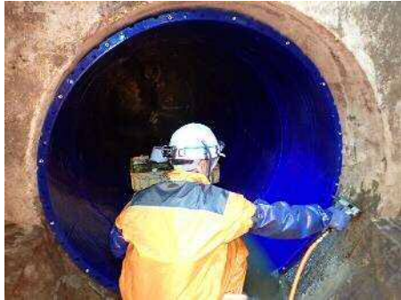
下水道管路の更生工事
