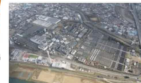
鳥羽水環境保全センター
