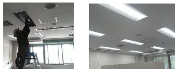
照明設備のLED化工事(水質管理センター水質第1課)
