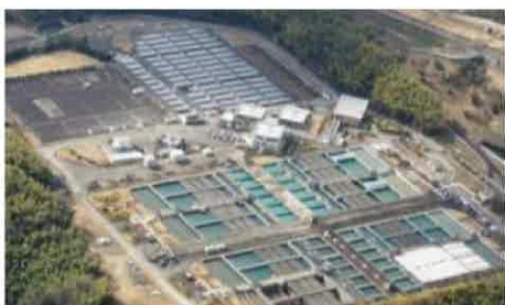
新山科浄水場
