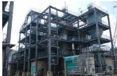
流動床式焼却炉の排煙処理設備 (鳥羽水環境保全センター)
