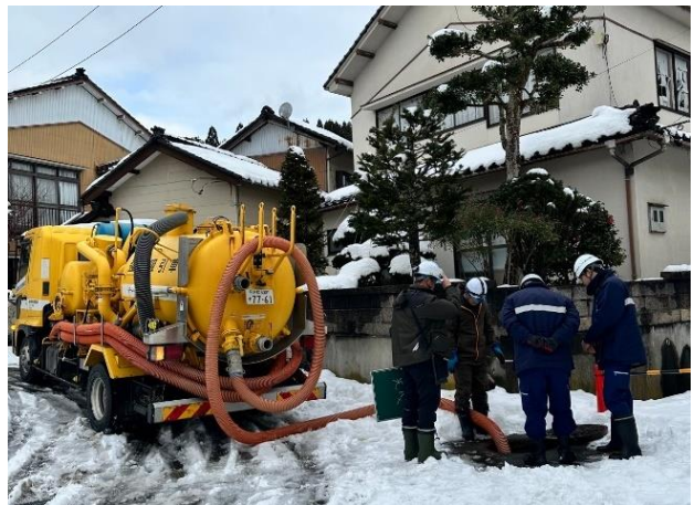
マンホール内の浚渫（排水）作業
