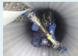
下水道管路の更生工事
