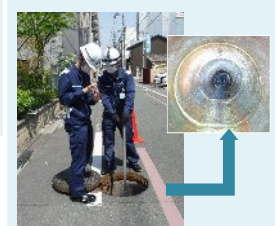
高画質カメラによる調査試行状況
