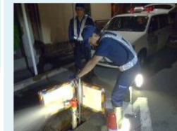
京の水道管おそうじプロジェクト (消火栓操作)
