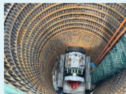
鳥羽第3導水きょ (発進立坑)
