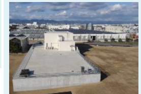
鳥羽水環境保全センター消毒施設 (塩素混和池)
