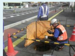
下水道管路の巡視・点検の様子
