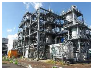
鳥羽水環境保全センター汚泥焼却施設 (流動炉)
