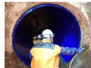
下水道管路の更生工事
