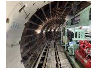
新山科浄水場導水トンネル築造工事(トンネル掘進の様子)
